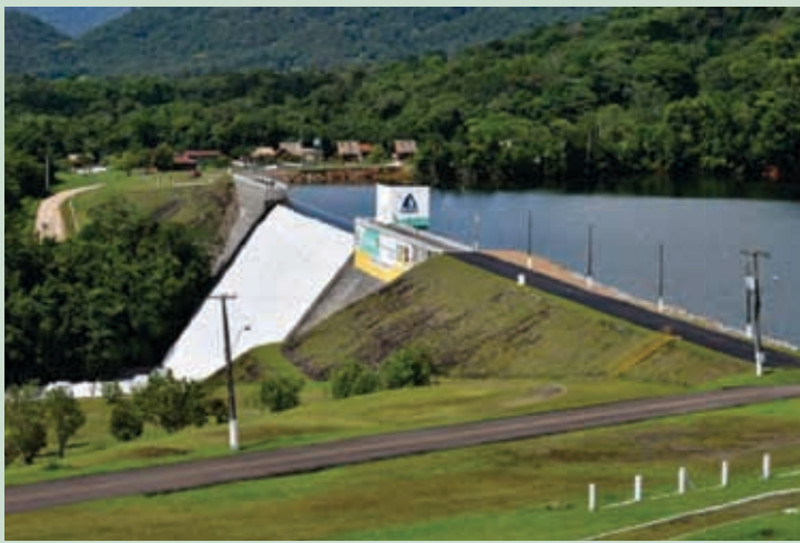
Rompimento de adutora da Casan na Barragem do Rio São Bento, em Siderópolis — Foto: Prefeitura Siderópolis/ Divulgação. https://g1.globo.com/sc/santa-catarina/noticia/2018/11/30/rompimento-de-adutora-da-casan-afeta-fornecimento-de-agua-em-6-cidades-do-sul-de-sc.ghtml . Acesso em 07/02/2020
