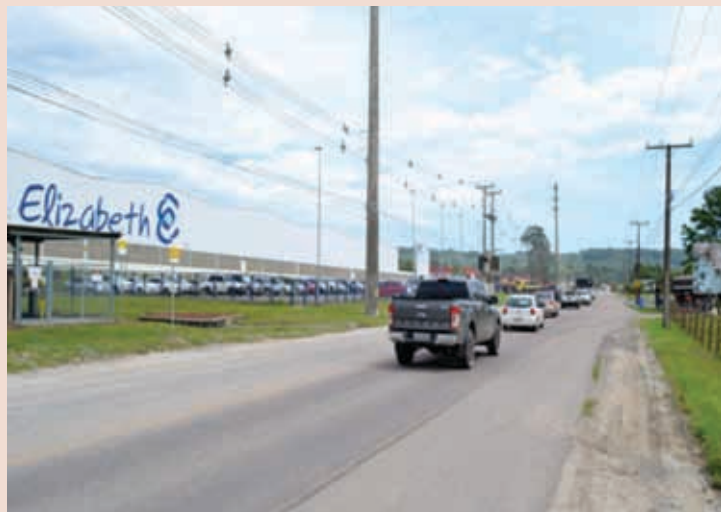
Área Industrial - Bairro Quarta linha
