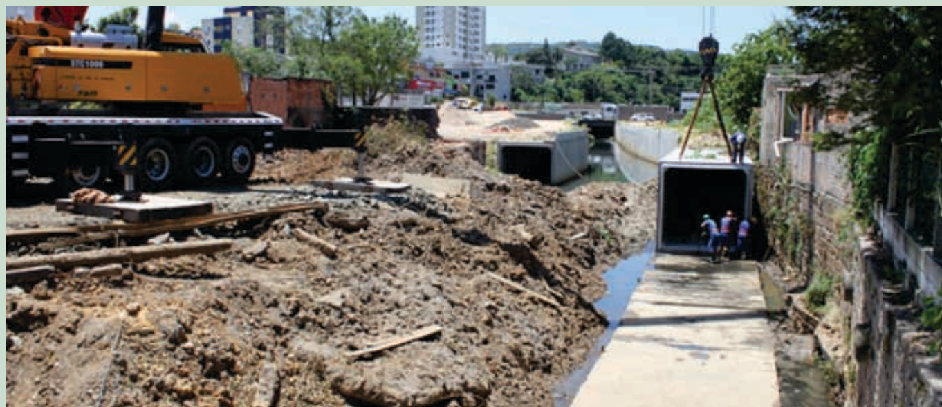
Construção do Canal Auxiliar FONTE: Arquivo /DECOM
