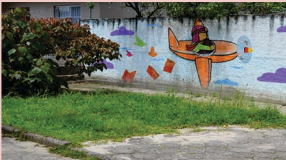
Muro da Escola Estadual Jarbas Passarinho Fonte: Secretaria Municipal de Educação de Criciúma (2020)
