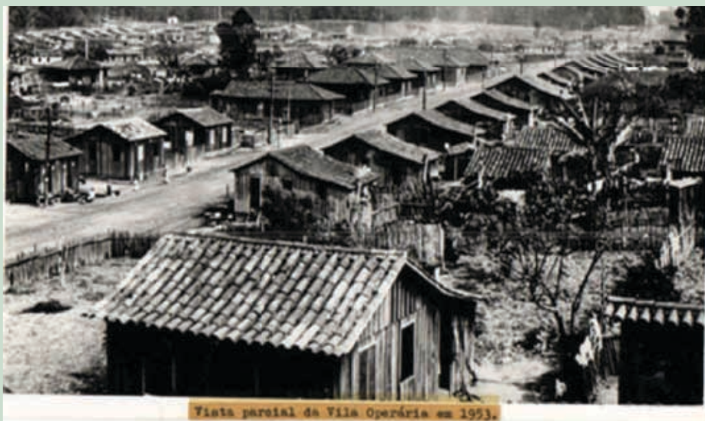
Vista Parcial da Vila Operária em 1953 Fonte: Arquivo Histórico Municipal Pedro Milanez
